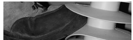
Abb. 34: Klettern auf Verbundisolatoren ist verboten
